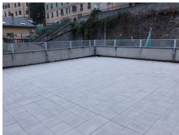
Figura 4.2 - Particolare della copertura, ripresa attraverso una griglia metallica
