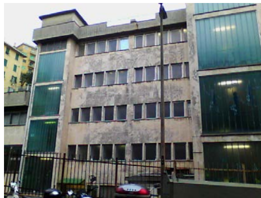
Figura 1.1 - Vista di una porzione della facciata Sud
