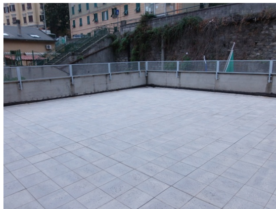
Figura 8.4 - Particolare copertura su cui intervenire.
