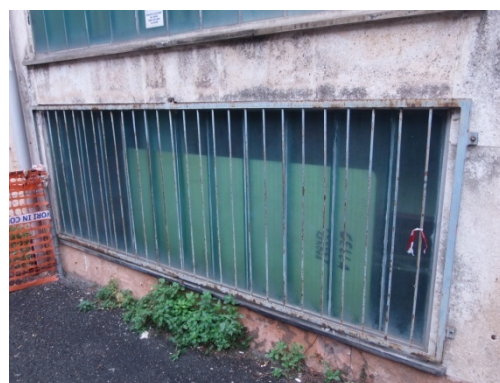
Figura 4.4 - Particolare dei serramenti - U-Glass
